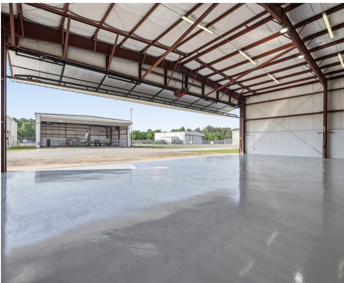
DOOR OPEN · DIRECT RAMP ACCESS
