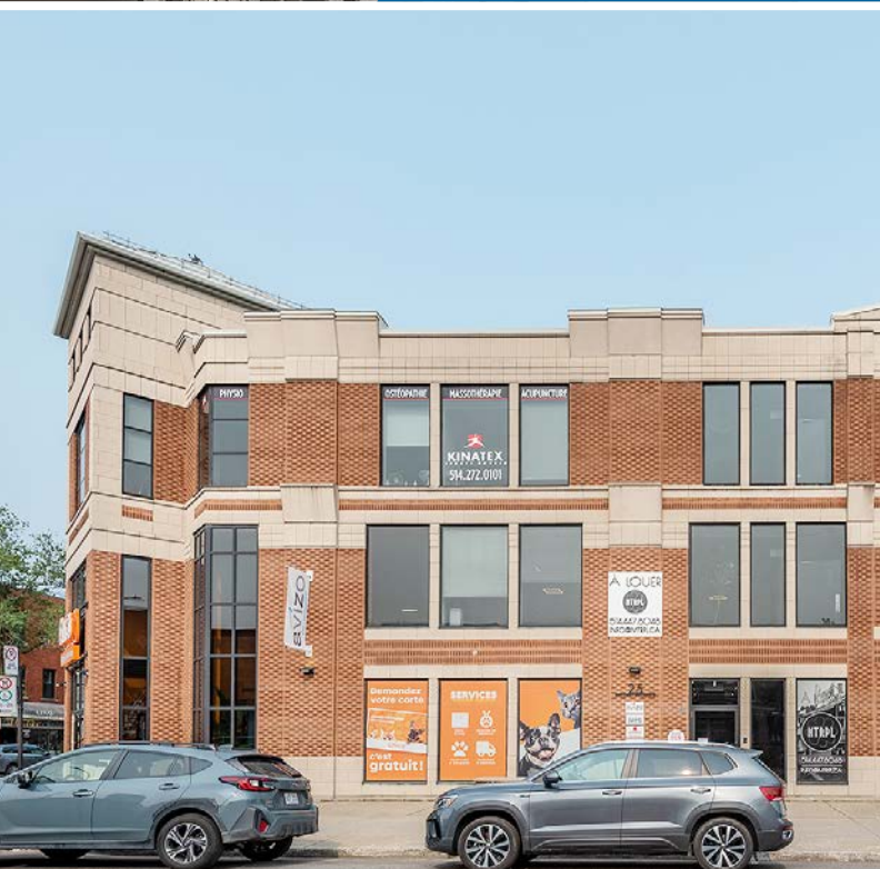
Vue latérale de l'extérieur | Exterior Lateral View
