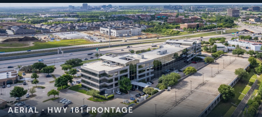
AERIAL · HWY 161 FRONTAGE
