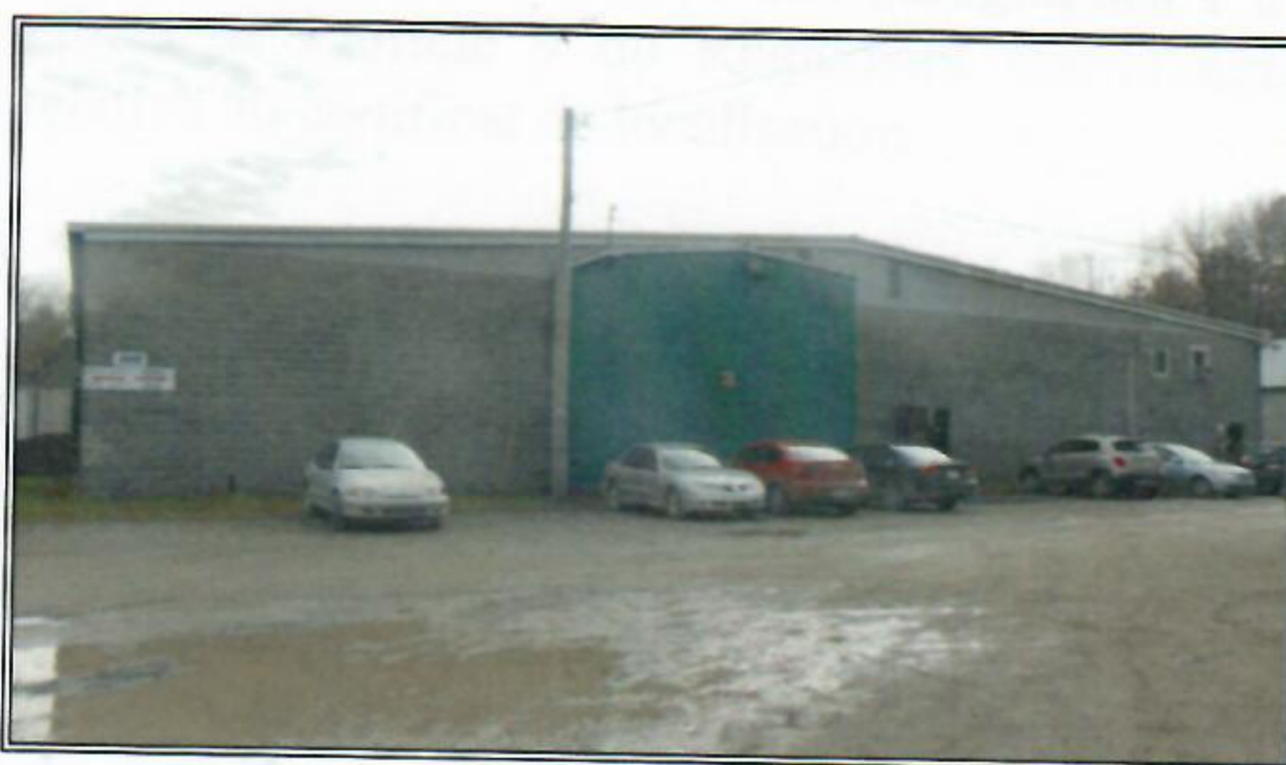
vue arrière du bâtiment
