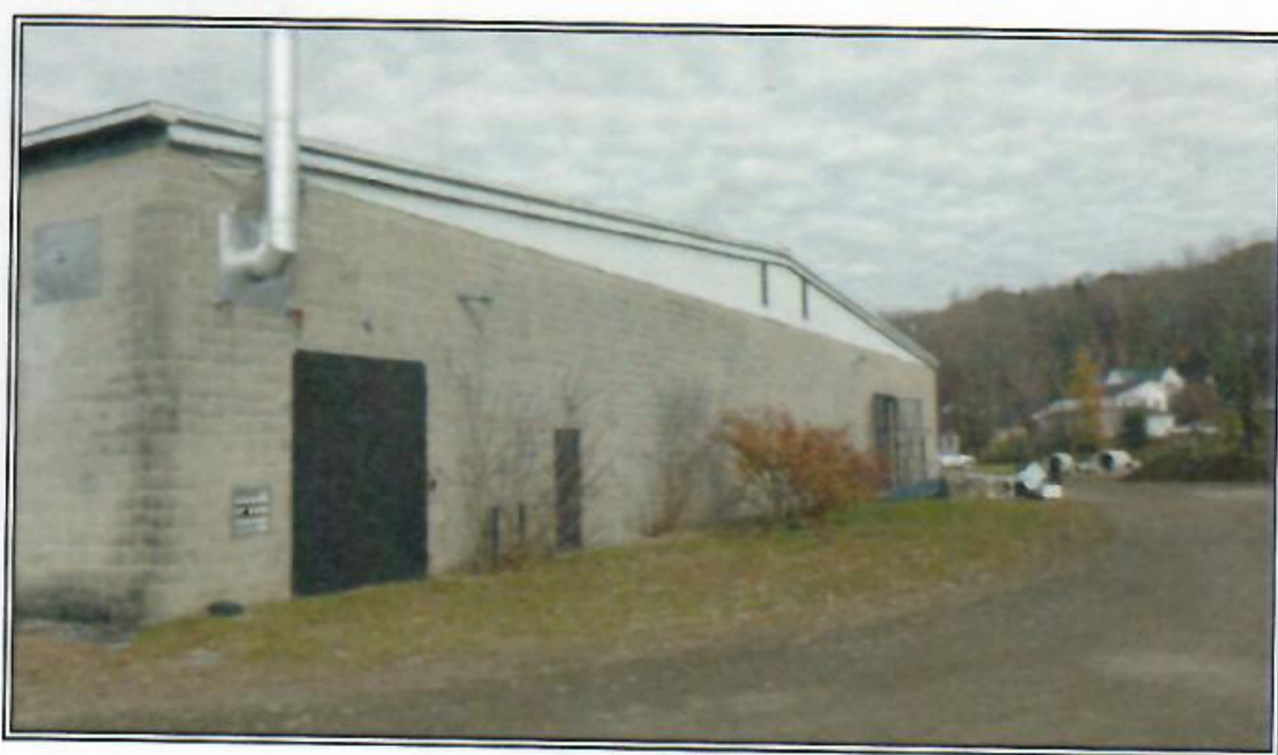
vue avant du bâtiment
