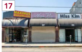
17 1015-1019 SAN JULIAN ST LOS ANGELES, CA
