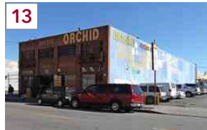
13 750 SAN JULIAN ST LOS ANGELES, CA
