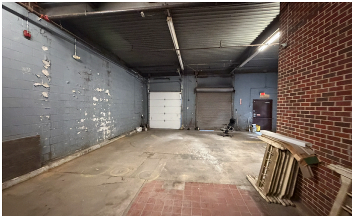
(2) 8'x8' Dock Doors
