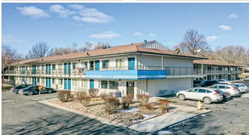
Motel 6 Des Moines, IA - North
