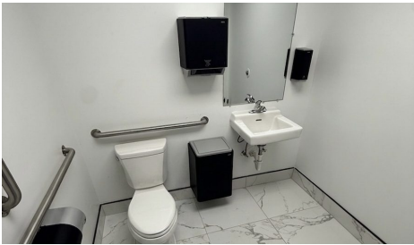
NEW ADA RESTROOMS
