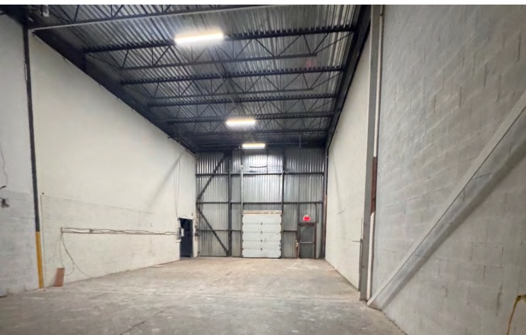
Unité | Unit 1324 Quai de chargement | Truck-level Door
