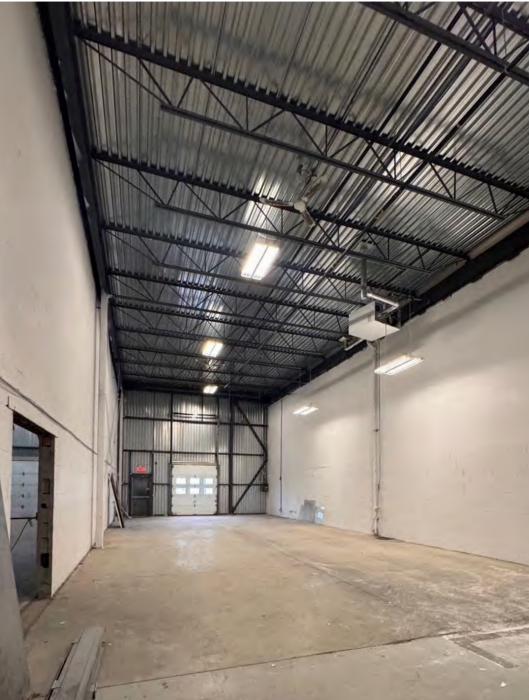
Unité | Unit 1330 Quai de chargement | Truck-level Door
