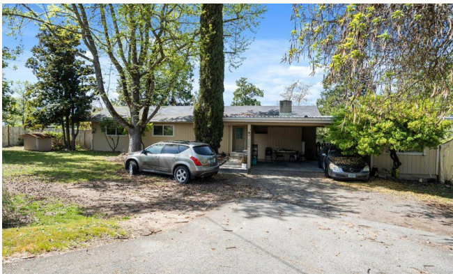
2090 Williams Hwy — 1955 · carport
