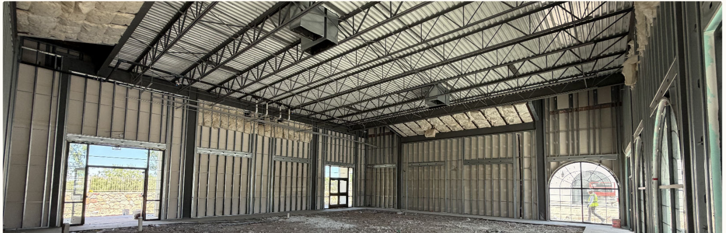
7345 PASEO DEL NORTE · INTERIOR SHELL
