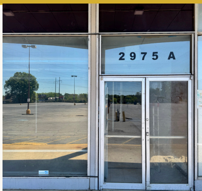
2975-A · Storefront Entry
