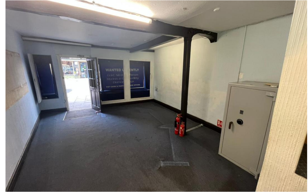
Tenant fitting out
