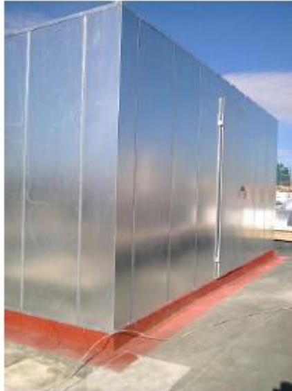
CERRAMIENTO ACÚSTICO PARA LA MÁQUINA SOBRE TORREÓN
