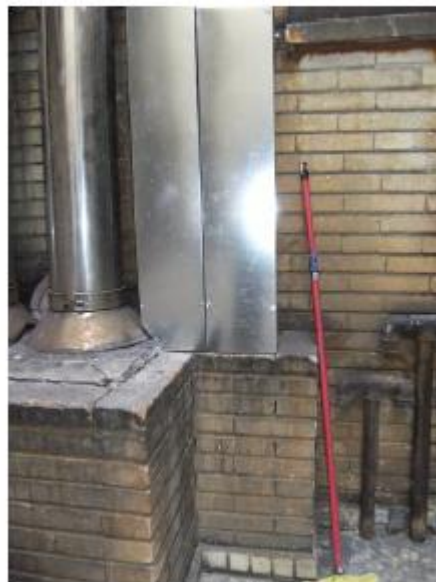
CONEXIÓN TUBERÍAS EN PATIO SOBRE CUBIERTA DE OFICINA
