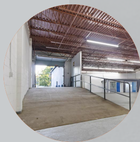
1 DOCK HIGH DOOR
