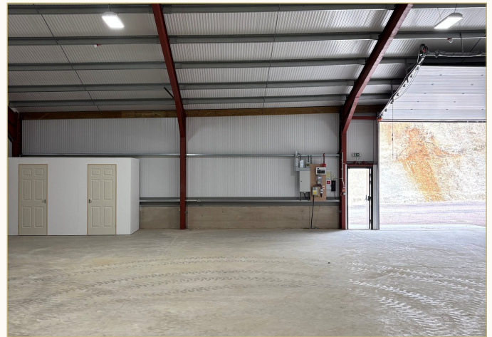
Interior — roller door & power fitout
