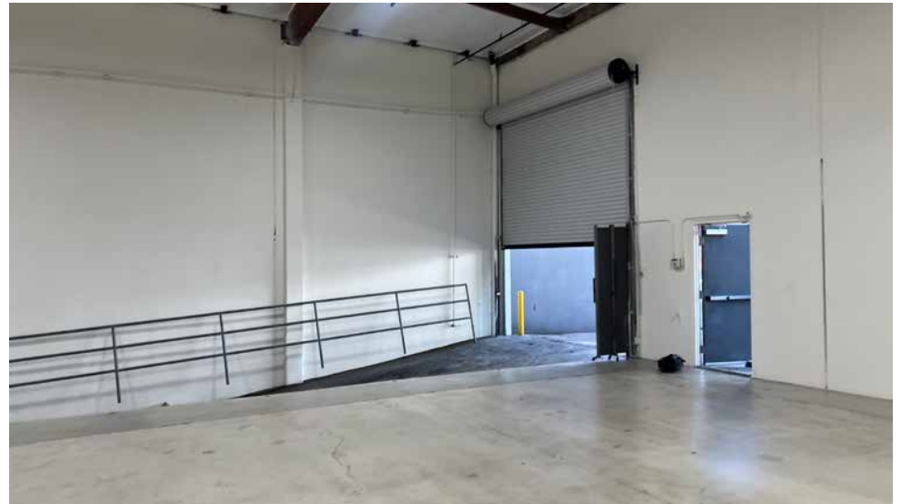
Ramp, DH Loading
