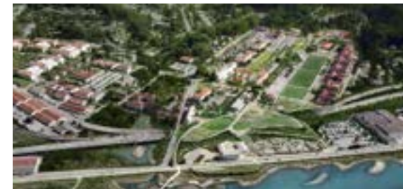
PRESIDO TUNNEL San Francisco
