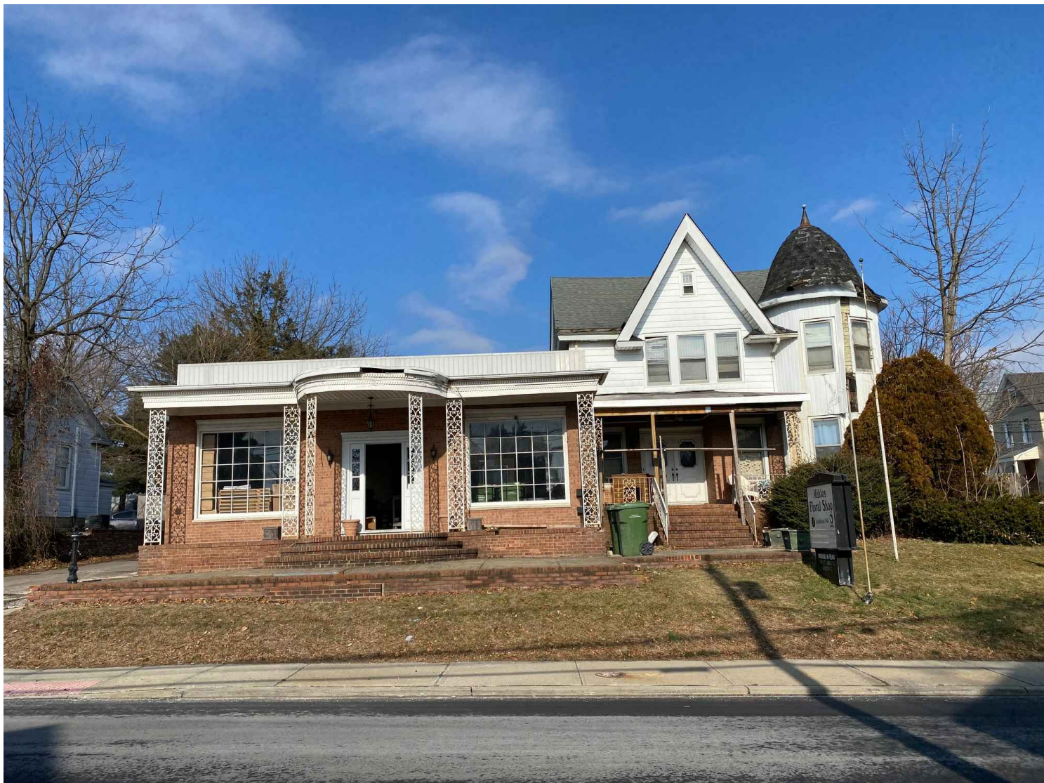
EXISTING CONDITION SCALE: N.T.S.
