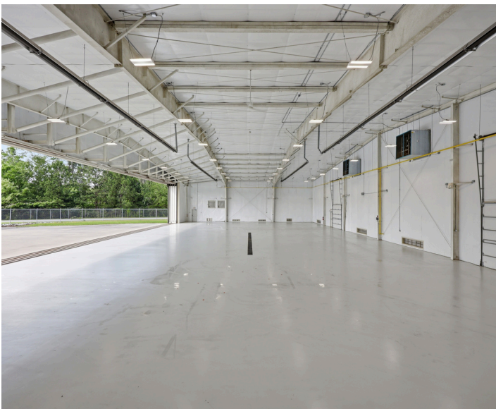
DOOR OPEN · DIRECT RAMP ACCESS
