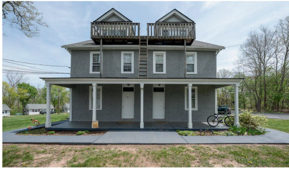
514/516 Main House - 4 units
