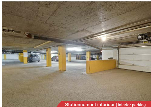
Stationnement intérieur | Interior parking
